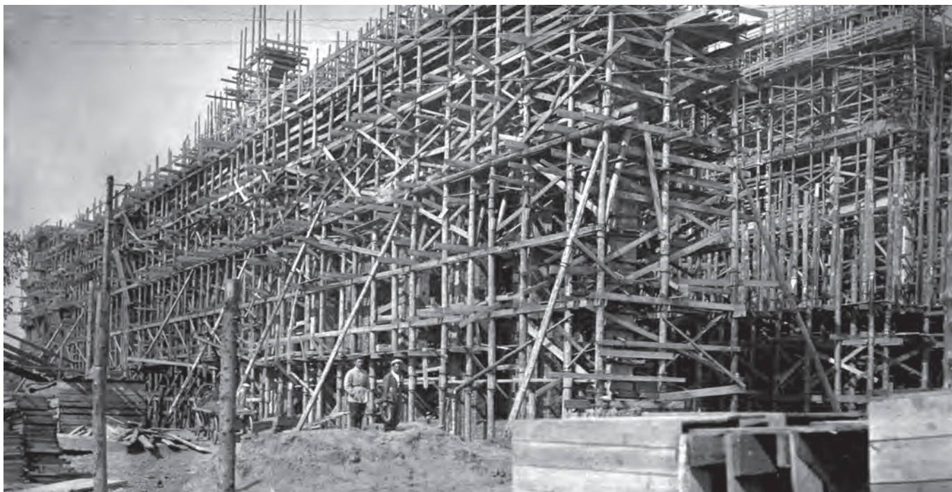
Возводится главный корпус ТЭЦ комбината № 392.
