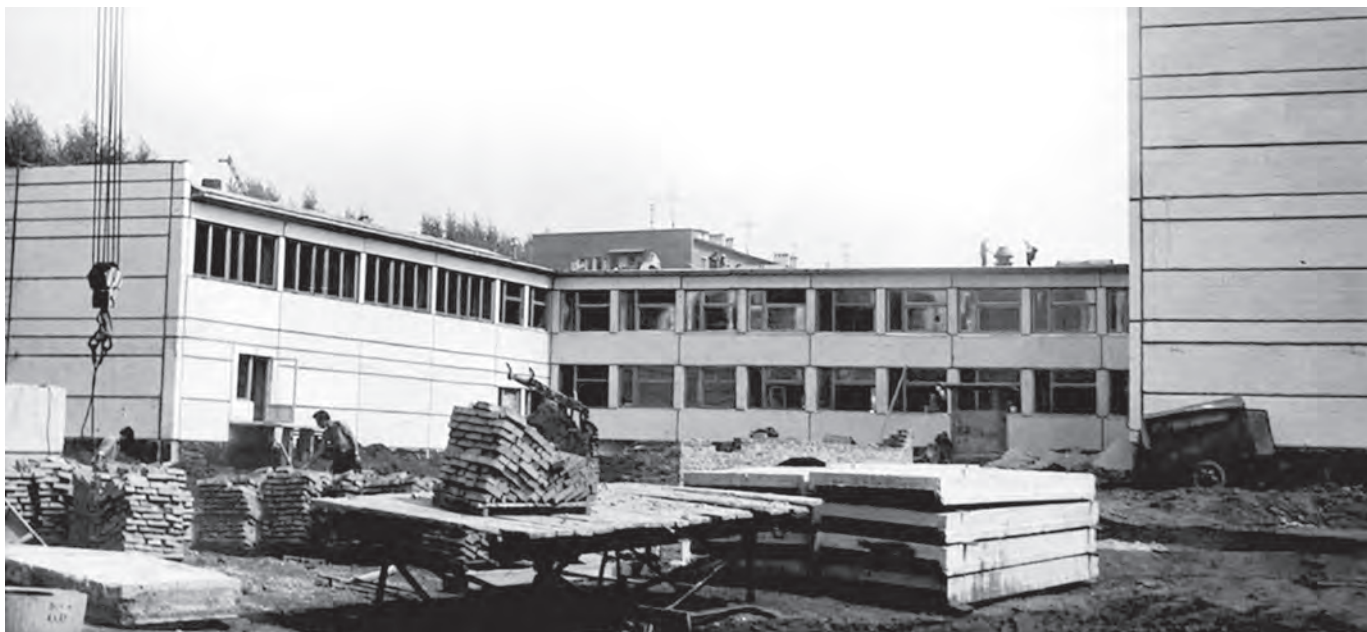
Возведение нового здания средней школы № 74.
