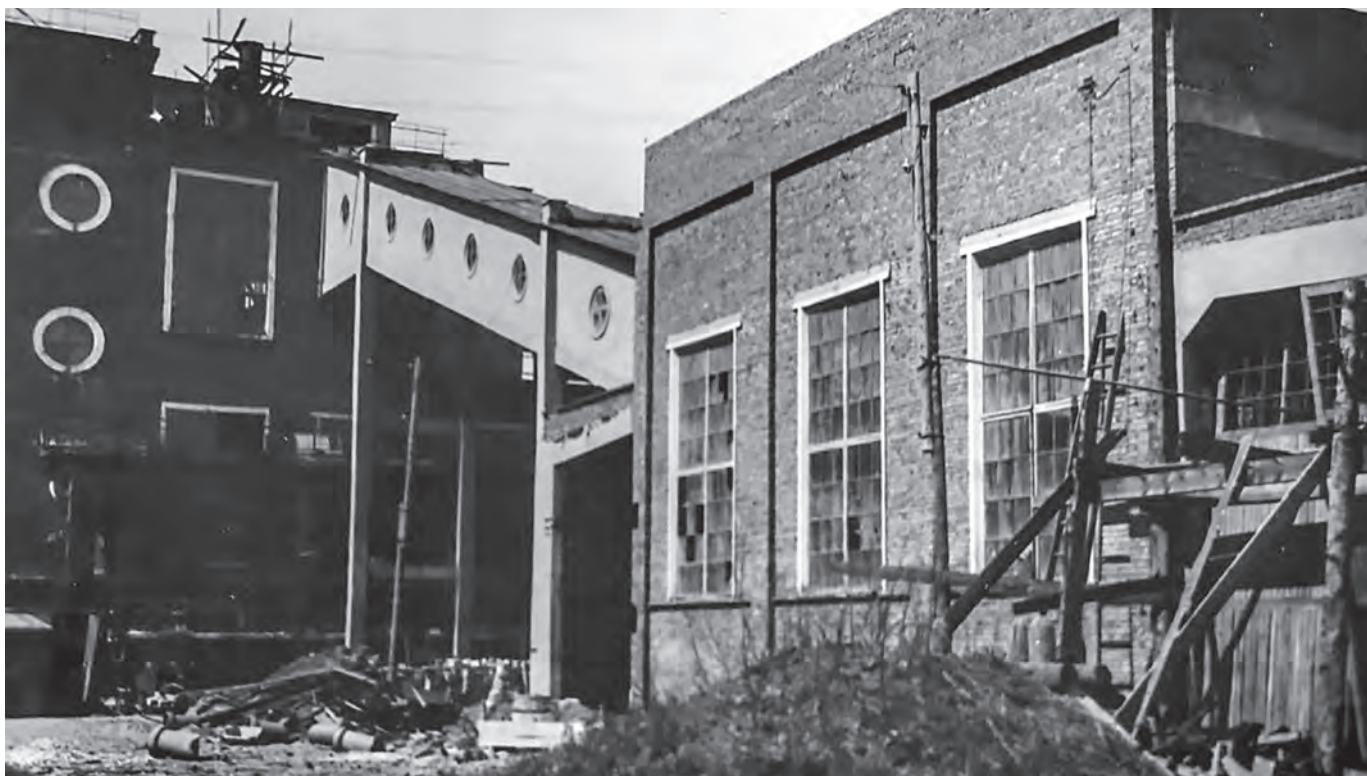
Строительство здания цеха №1.
