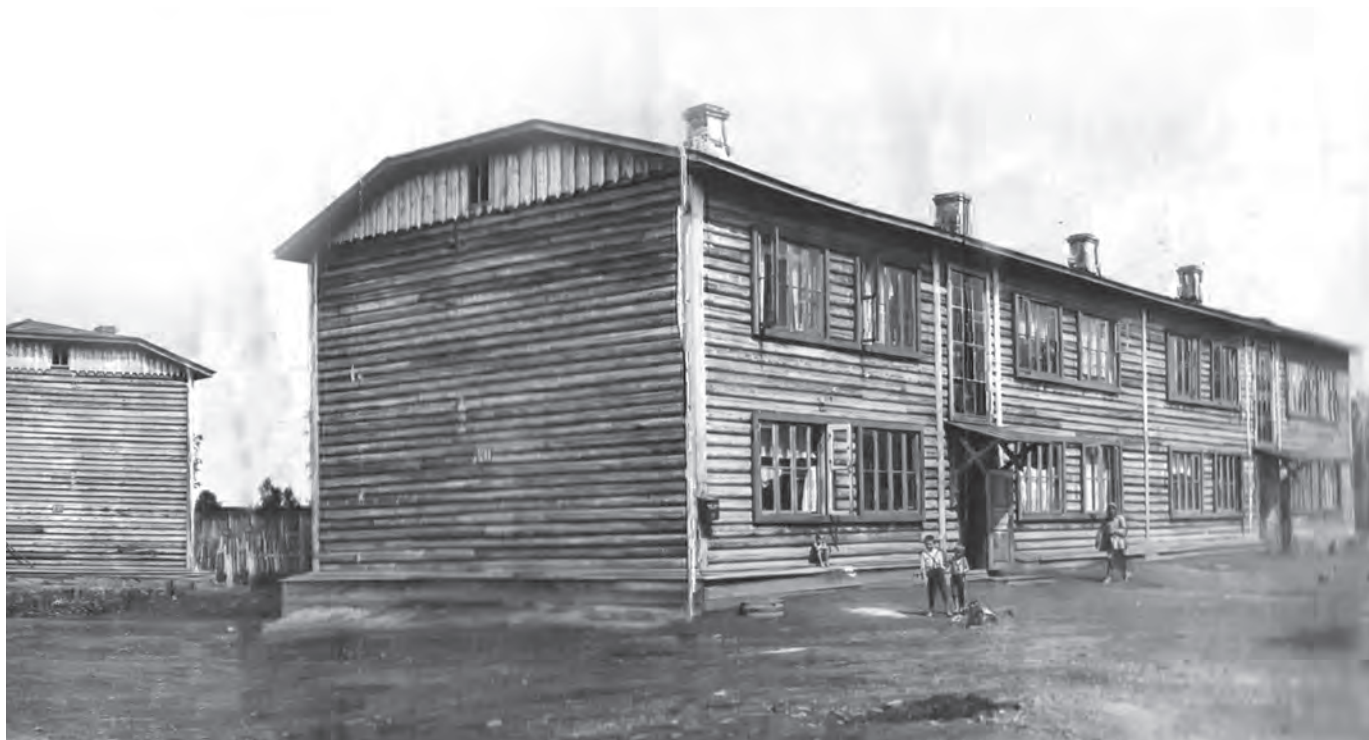
Временный поселок строителей на 3-м участке. 1933 г.
