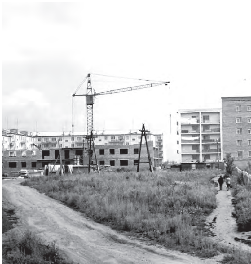
Строительство 21-го микрорайона.
