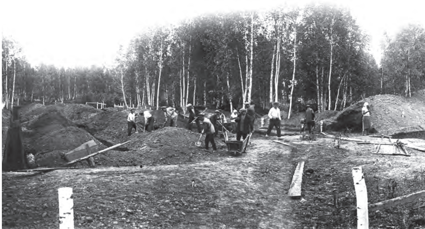
Строительство домов в центре будущего Кировского района. 1934 г.
