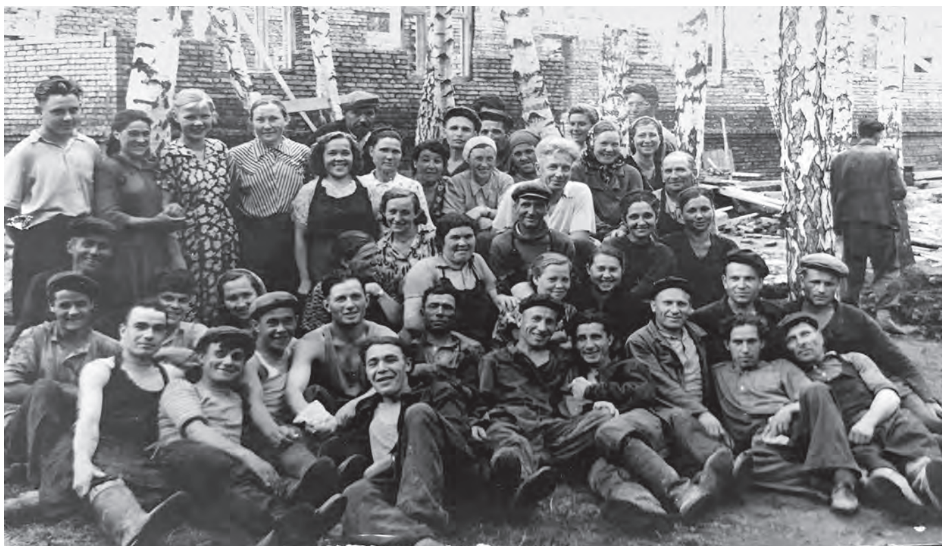
Рабочие комбината № 392 на субботнике. Возведение корпусов новых цехов – дело общее.
