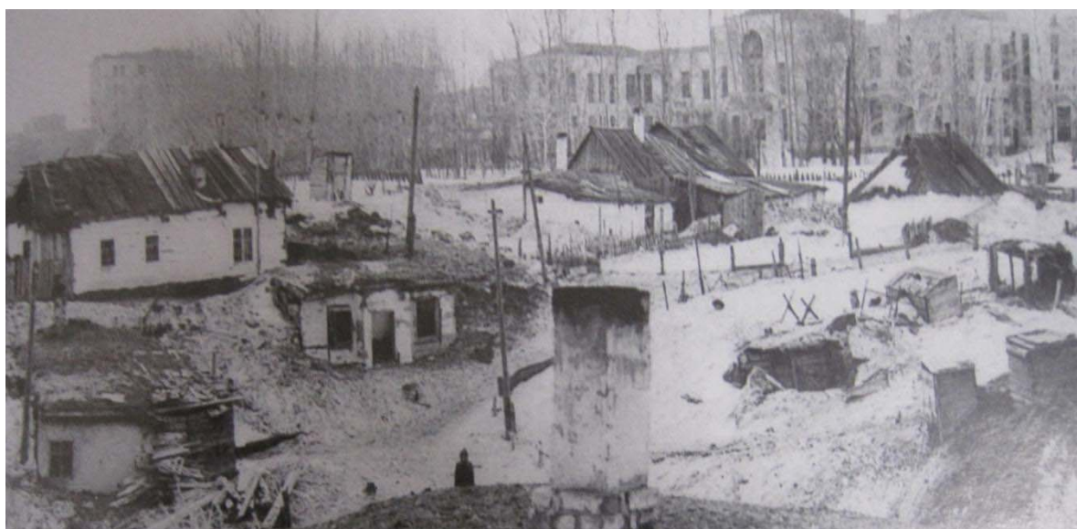
Корпус больницы Кузнецкого округа, построенной в Щегловске в 1928 г.
